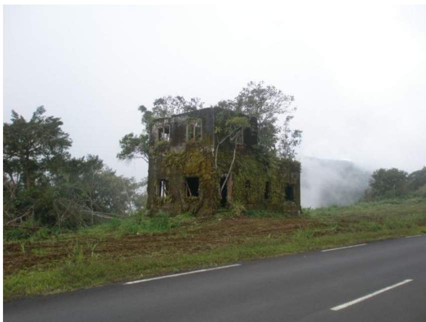
LA ANTIGUA CASA DE OBRAS PÚBLICAS, EN EL MIRADOR
